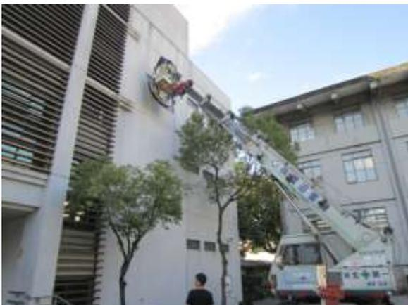
作品主體物件以吊車進行外牆安裝作業。
