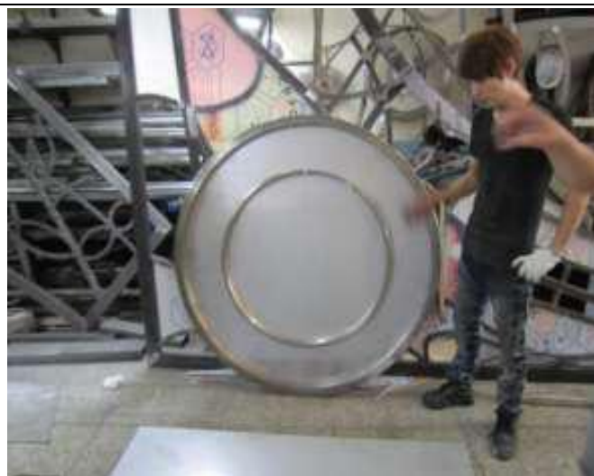
外牆主體物件底盤及外框製作完成
