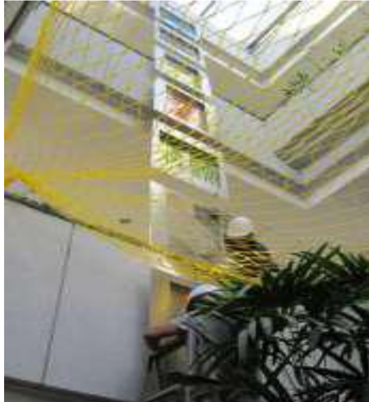
中庭懸吊物安裝施工過程。
